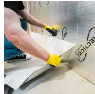
18. Poista alumiinipinnoite eristelevyn pinnasta siitä kohdasta, johon sokkelilaatoitus asennetaan. Alumiinipinnoite lähtee helpoimmin irti siitä puolelta levyä, johon ei ole painettu kooditekstiä.
