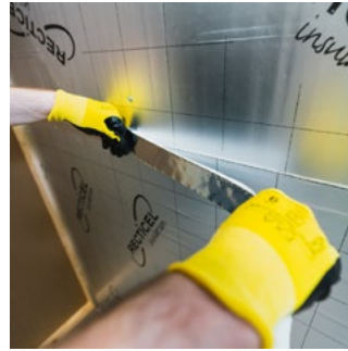
14. Teippaa kaikki liitoskohdat alumiiniteipillä. Teippaa myös läpivientien ja lauteiden saumaukset sekä kiinnikkeiden kannat.
