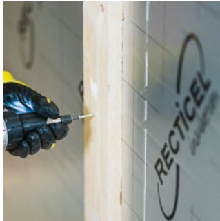
16. Asenna saunan seinään rimat paneelointia varten. Kiinnitä rimat eristelevyn läpi naulatulpilla tai ruuveilla taustalla olevaan runkoon. Suosittelemme käytettäväksi vähintään 20 mm paksua rimaa, jotta paneelin ja eristeen väliin jää riittävä ilmarako.
